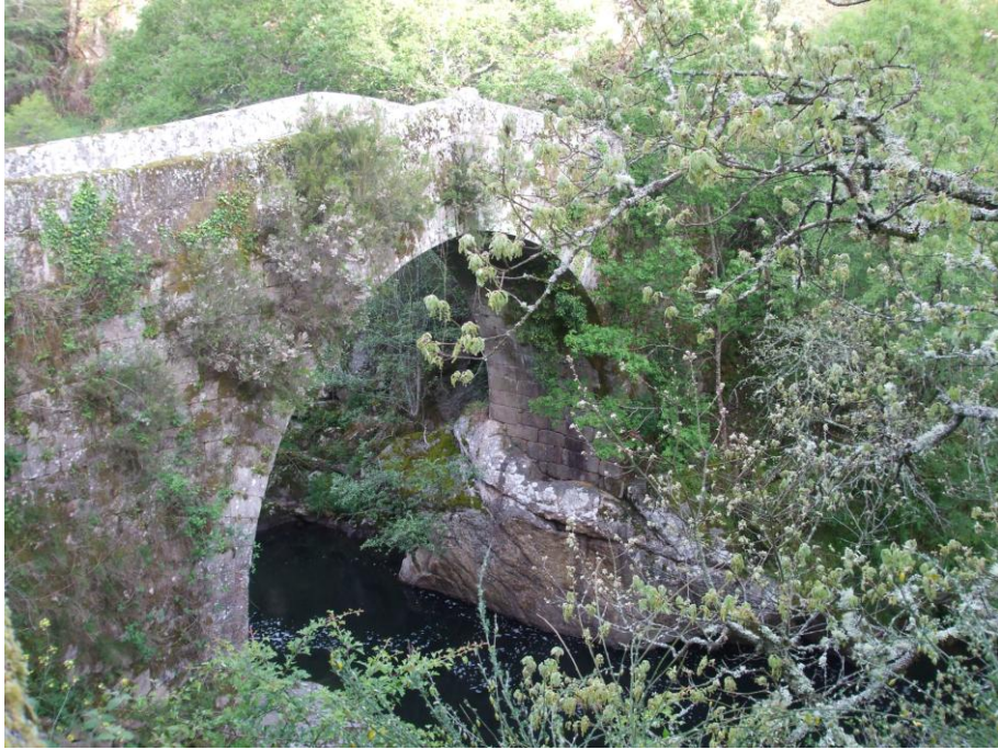
Ponte romano di Taboada
