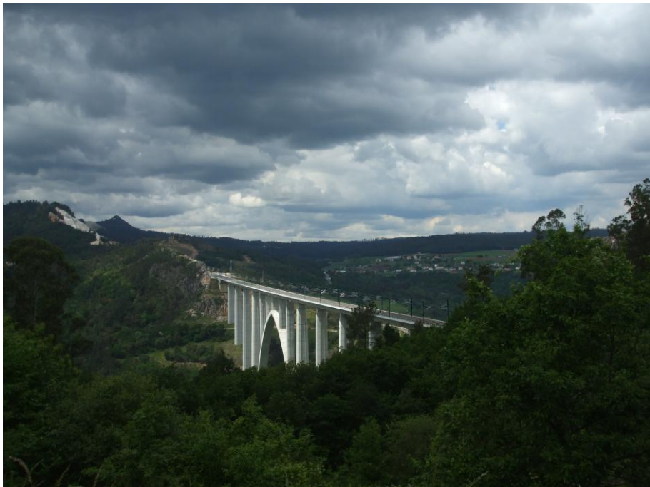
Verso Ponte Ulla, modernissimo ponte ferroviario (Ave)
