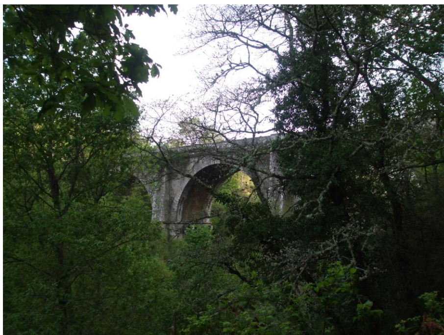
Tra Borralla e Taboada, ponte stradale sul Rio Deza
